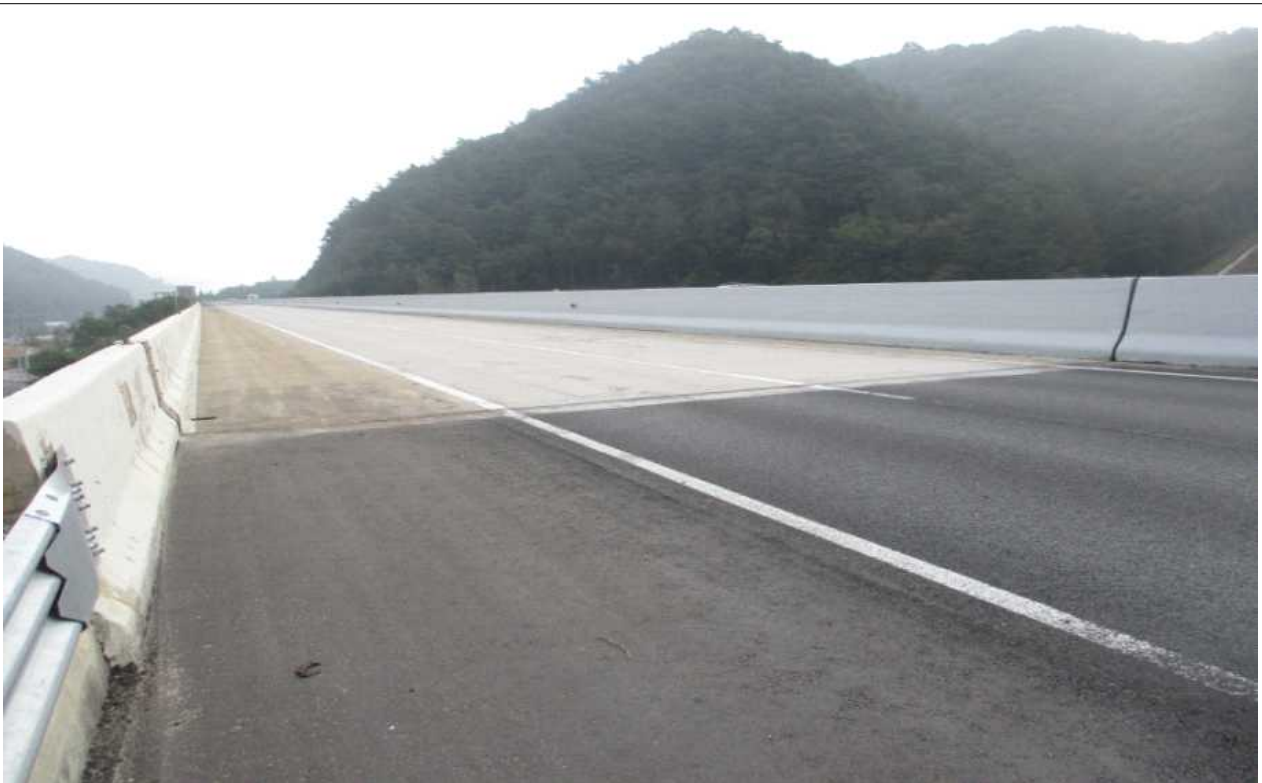
교량 상부 전경
